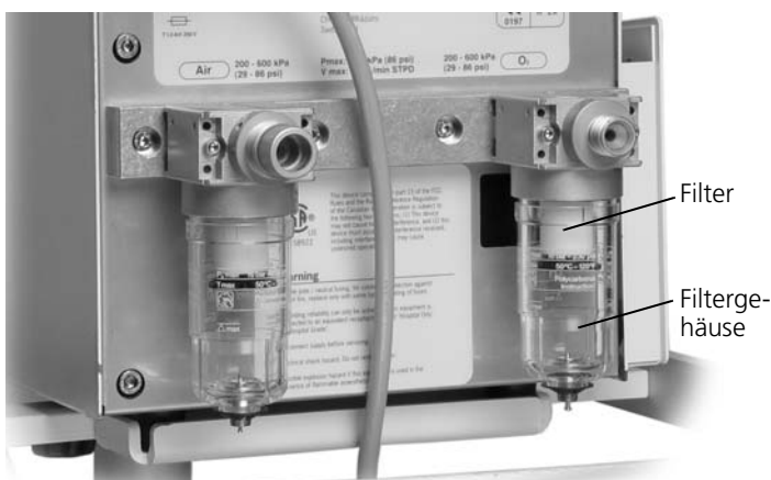
Abbildung 8-2. Austausch eines Gaszufuhrfilter
